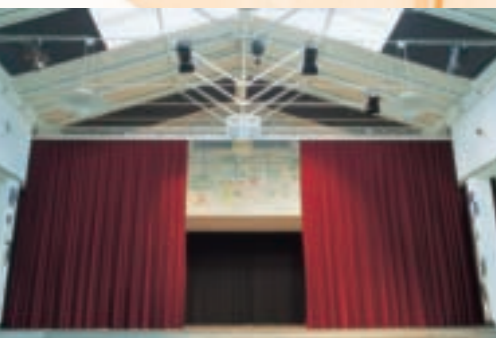
Alu-Vorhangschienen mit Bühnenvorhang JMS-Gymnasium, Dillingen (oben: Satteldach-Vollverdunkelung)
