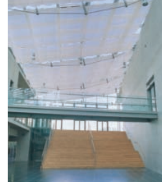
Horizontale Raffanlage, Stadthalle Tuttlingen
