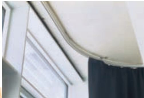
Gebogene Alu-Vorhang-Schiene LFU, Augsburg
