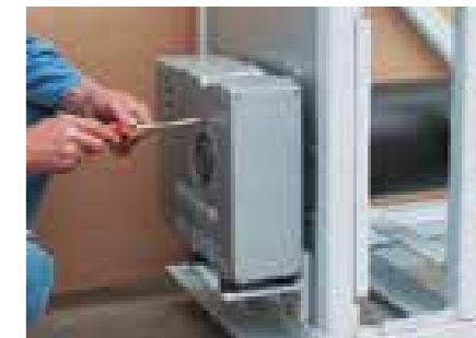
Aufsteckmotor 400 VAC, Revisionsmöglichkeit des Motors ohne Ausbau der Behangwelle.
